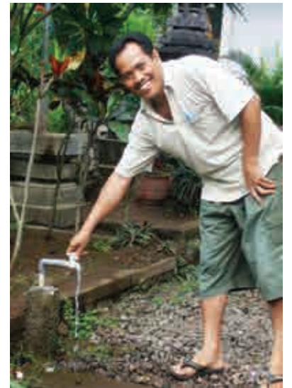
Réparation des tuyaux d'eau au collège d'Abang N3 ; 10.500.000 roupies
